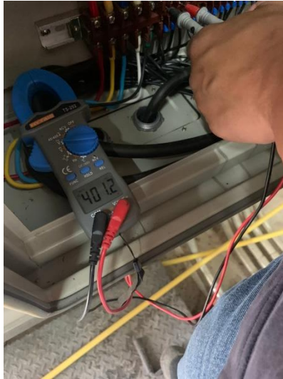
แรงดันไฟฟ้า 3 เฟส ปกติ (401.2 โวลต์)
