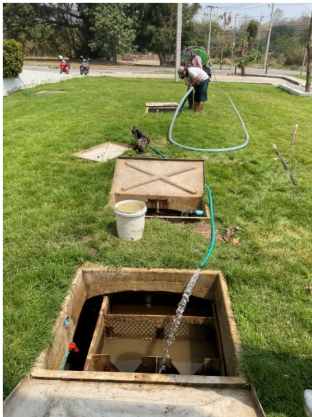
รูปขณะทำการเติมน้ำเข้าบ่อ
