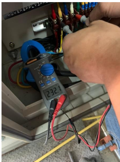
แรงดันไฟฟ้า 1 เฟส ปกติ (232 โวลต์)
